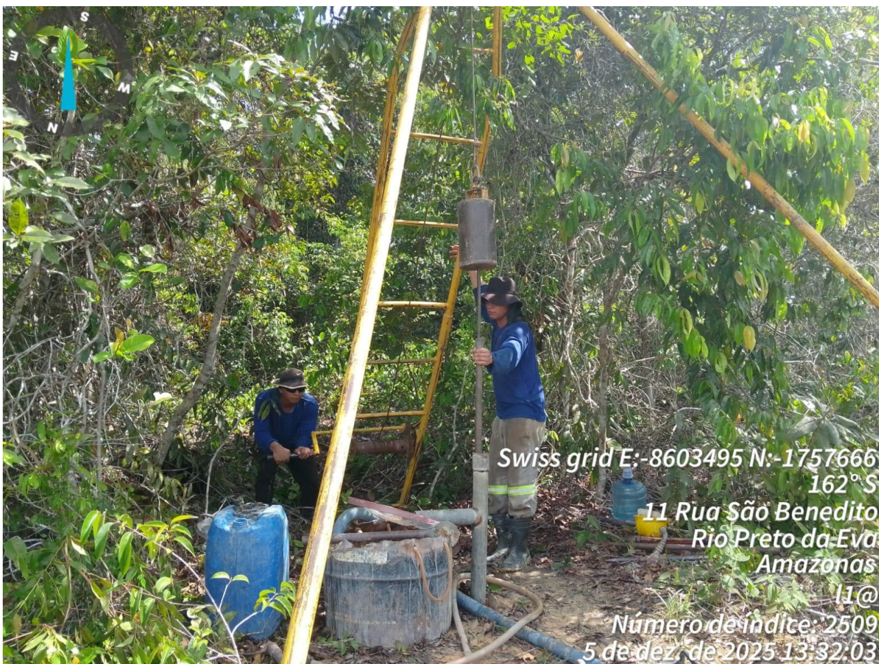
Foto 01 – Execução da Sondagem
